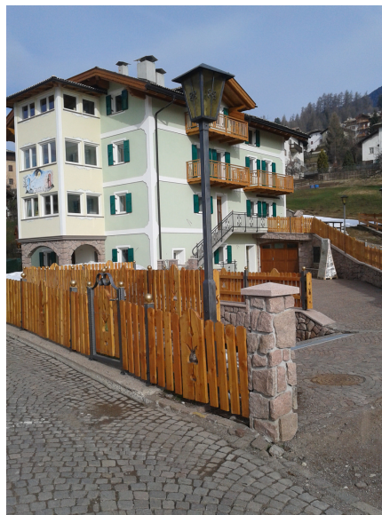
Fig. 13 Armatura artistica 100W SAP (Via S. Tommaso)
