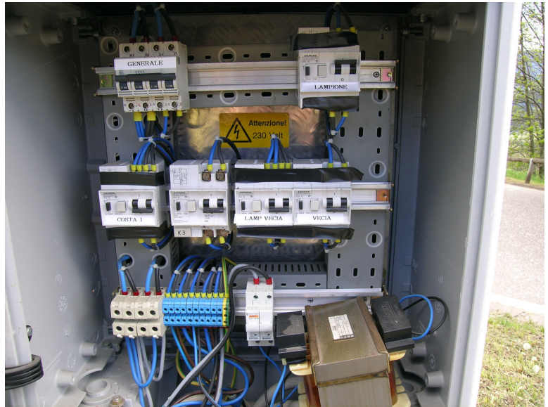
Fig. 9 Particolare quadro elettrico generale I.P. a Daiano (Q02)
