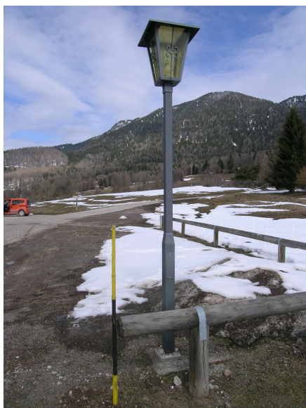
Fig. 14 Armatura artistica 70W SAP (Via Prabocolo)
