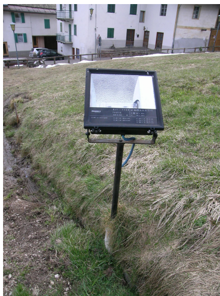
Fig. 15 Proiettore 250W HQI (Via Ancona)
